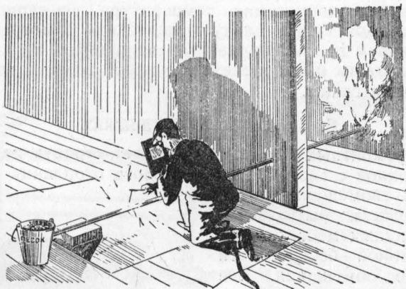
Рис. 28. Опасная сварка трубопроводов.
